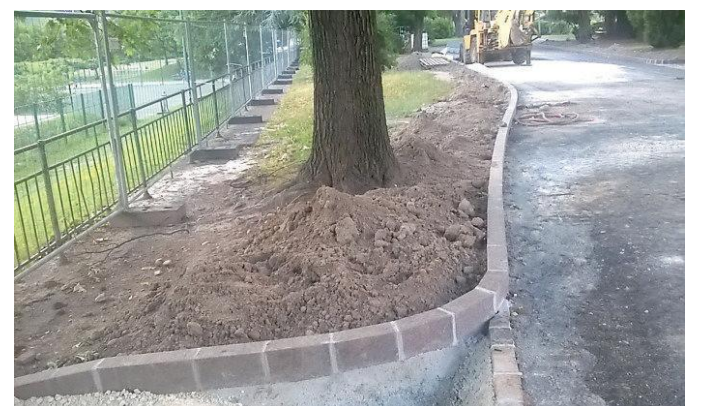
I lavori eseguiti lungo le passeggiate del Talvera
